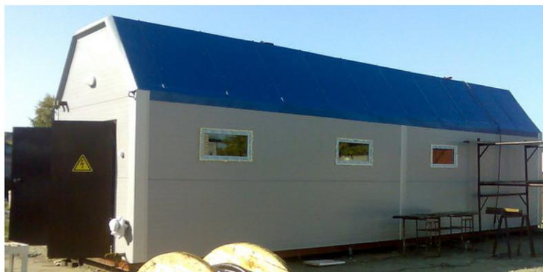
Рис. 1. Блочно–модульная компрессорная станция
