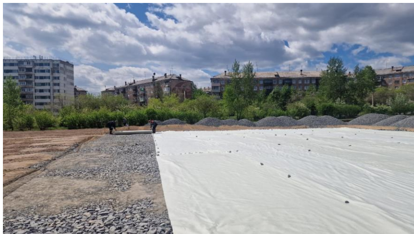
Рис.2. Этап укладки геополотна нетканого ФОКОТ по бул. Космонавтов
