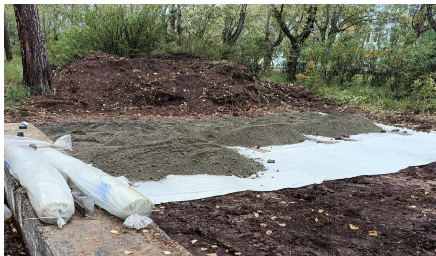
Рис.1.Этап укладки геополотна нетканого на объекте благоустройства в ж.р. Падун
