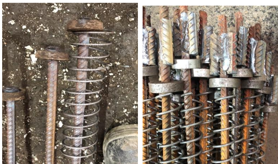
Рис. 4. Временные концевые анкера
