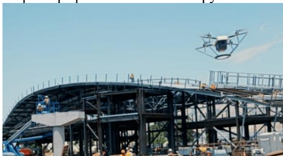
Рис. 1. Применение дронов для автоматизированной инспекции строительных площадок
